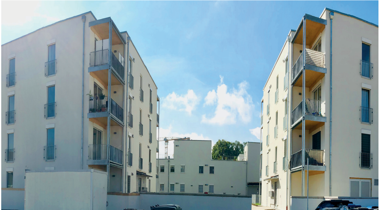
Mieterstromprojekt in München realisiert durch die Firma Polarstern GmbH
